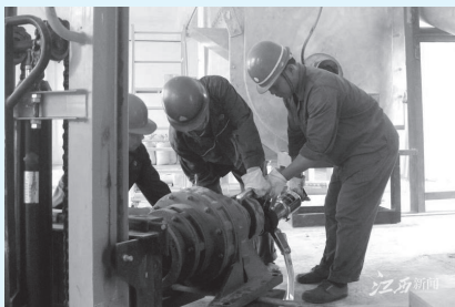
图 1-13 刘向阳和同事在维修出现故障的减速机
