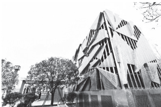
图 2-9 武汉地铁 3 号线的通风亭
