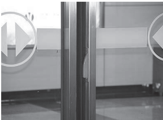
图 2-19 屏蔽门解锁装置
