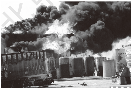
图1-9 静电引起的易燃液体的爆炸
