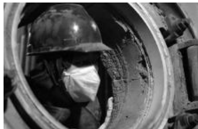
图 2-2-7 人孔中正在作业的工人
