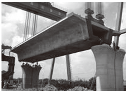
图 2-1-16 开始安装桥梁支座
