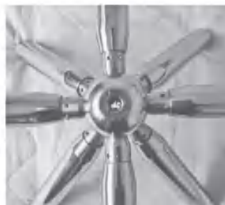
(b) 螺栓球节点实例图片
